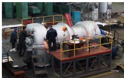
Консервация газовых турбин
